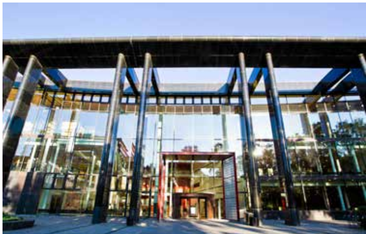
Fredet: Universitetsbiblioteket på Blindern, Georg Sverdrups hus, fra 1999. Bygningen er tegnet av Telje-Torp-Aasen Arkitekter A/S. FOTO: VEGÅRD GRØTT/NTB SCANPIX
