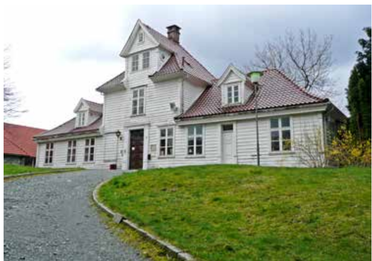
Fredet: Fastings Minde, Universitetet i Bergen. Den eldste delen er fra 1790. FOTO: STATSBYGG
