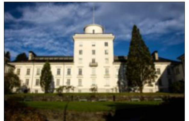
PERFEKT SYMMETRI: Anlegget i tilknytning til Vervarslinga på Vestlandet, eller «geofysen», er Moes personlige favoritt i Bergen. Parken er inspirert av 1920-tallets nyklassisisme.
