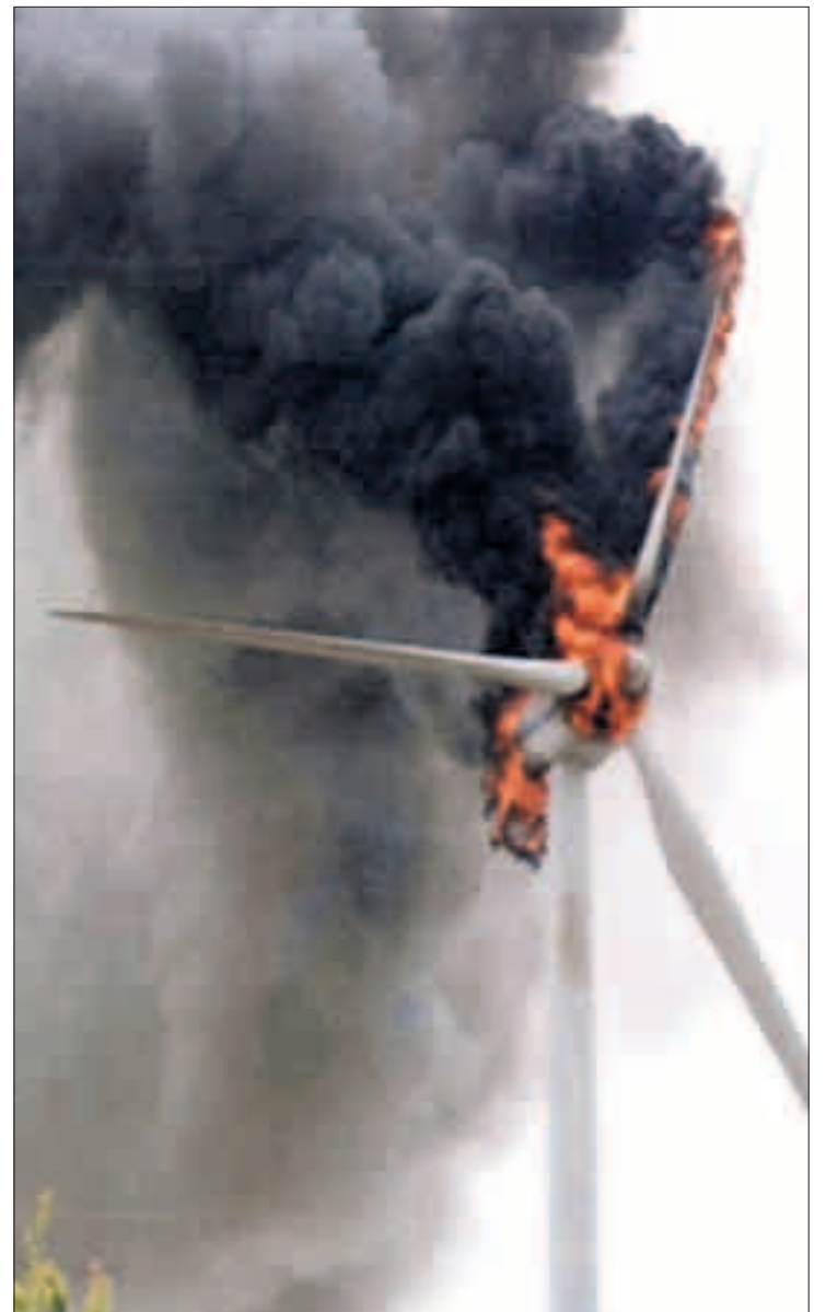
VINDMØLLEHAVARI: Bildet viser et havari hvor brennende deler regner mot bakken med risiko for skogbrann. Havarierne vil gi store ekstraomkostninger, særlig når det gjelder vindmøller til havs.
