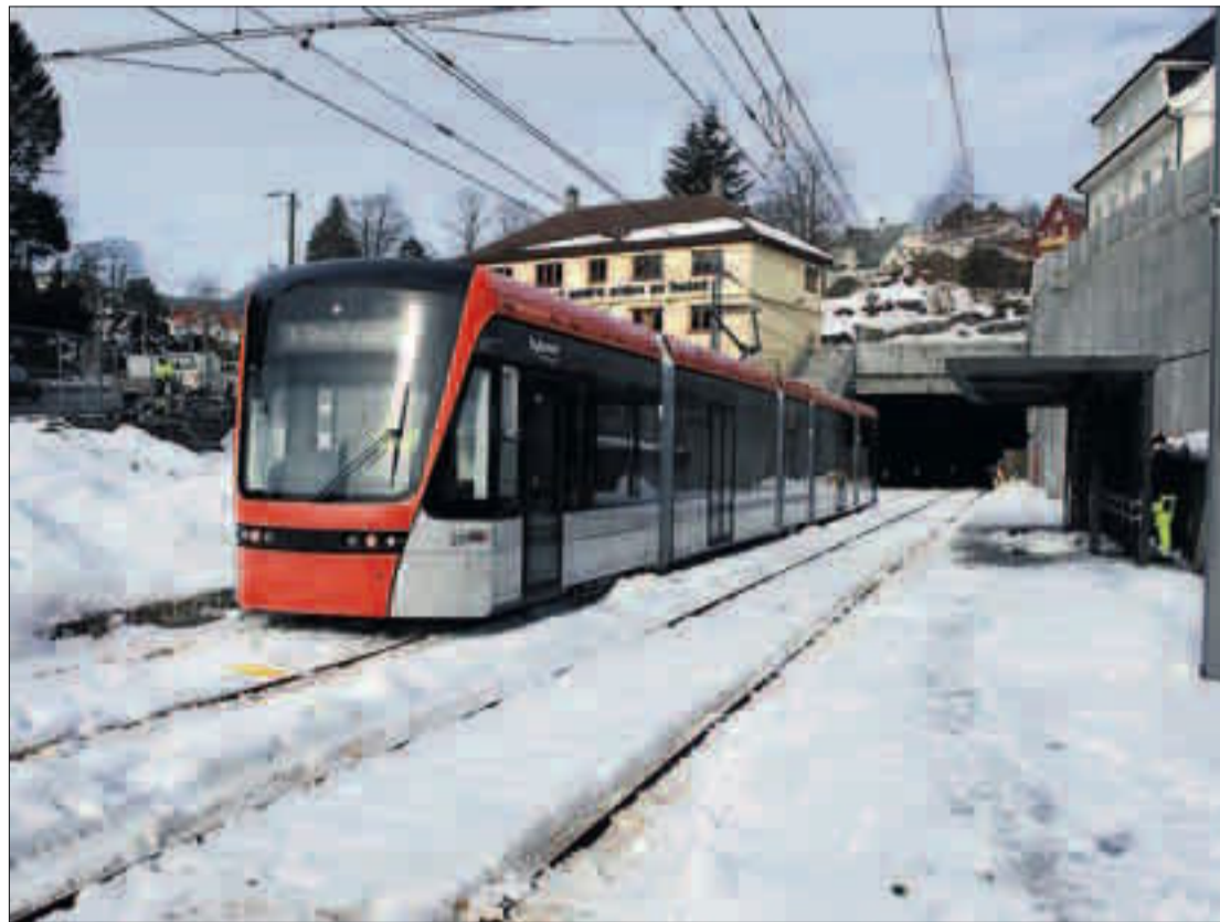
PARADIS STASJON: Vi må iverksette alle de tiltak vi kan for å forebygge skader på liv og helse – uansett kostnad. Her er det testkjøring på Bybanen første gang i mars 2010.
